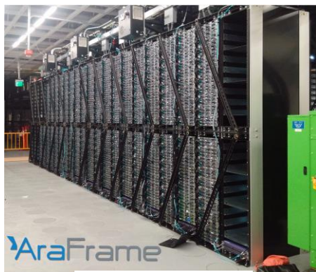
60U Server Racks
